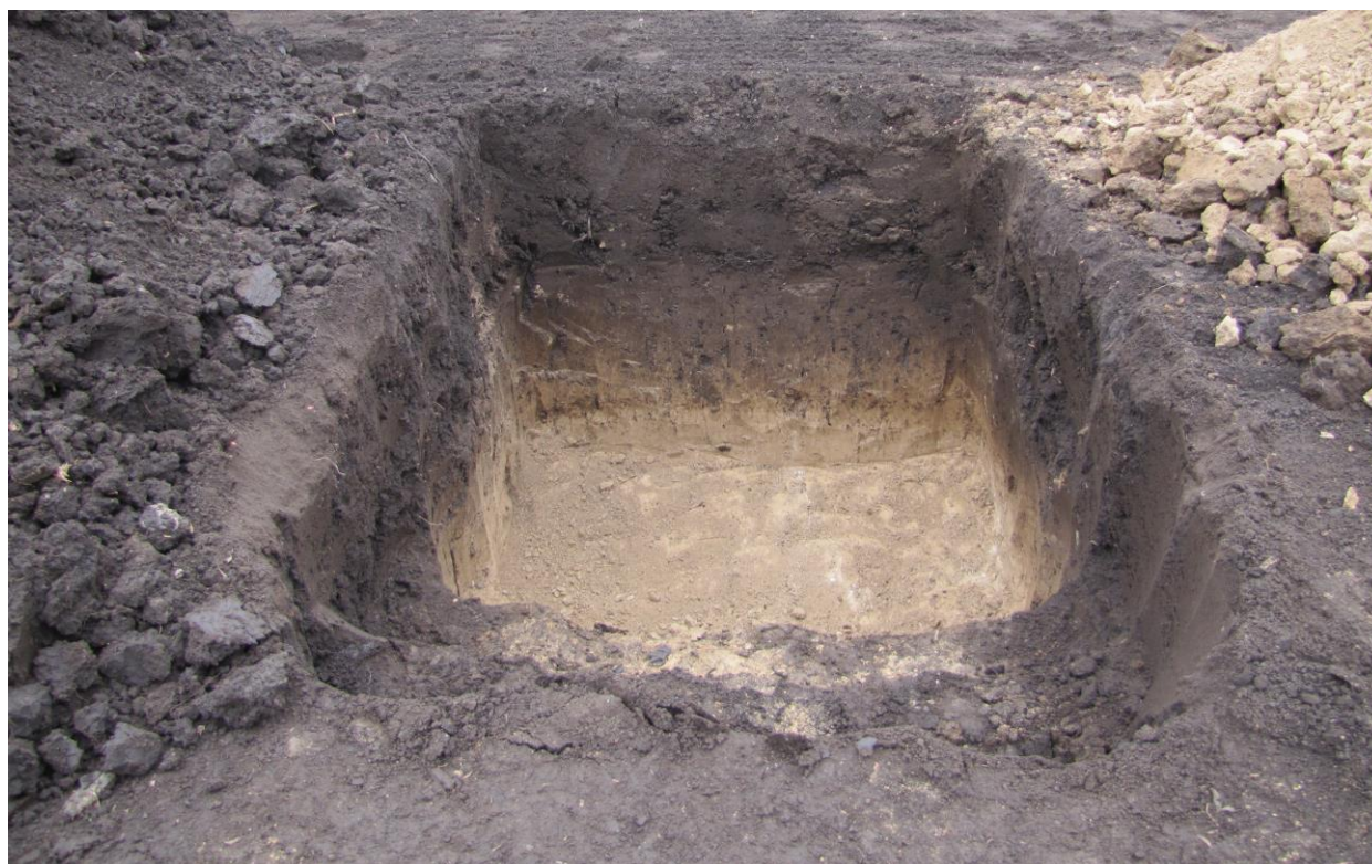
Foto 26: Výkop půdní sondy na pozemku Hranice, jaro 2017
